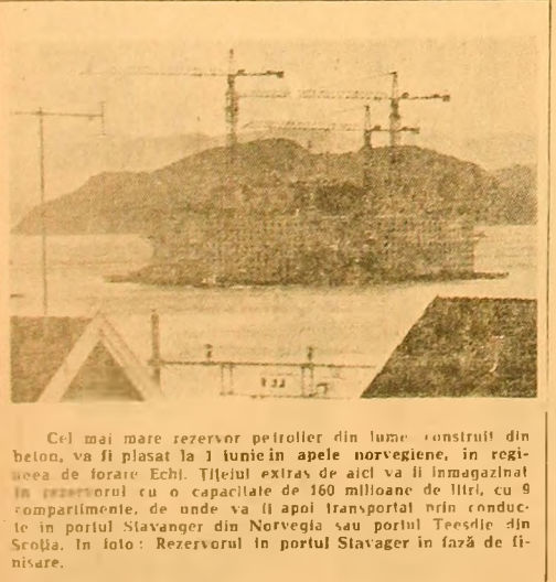
Cel mai mare rezervor petrolifer din lume, construit din beton, va fi plasat la 1 tunie în apele norvegiene, în regiunea de forare Echl. Titeul extras de aici va fi immagazinat în rezervorul cu o capacitate de 160 milioane de litri, cu 9 compartimente, de unde va fi apoi transportat prin conducte în portul Stavanger din Norvegia sau portul Teeside din Scoția. În loto: Rezervorul în portul Stavanger în fază de finalizare.
