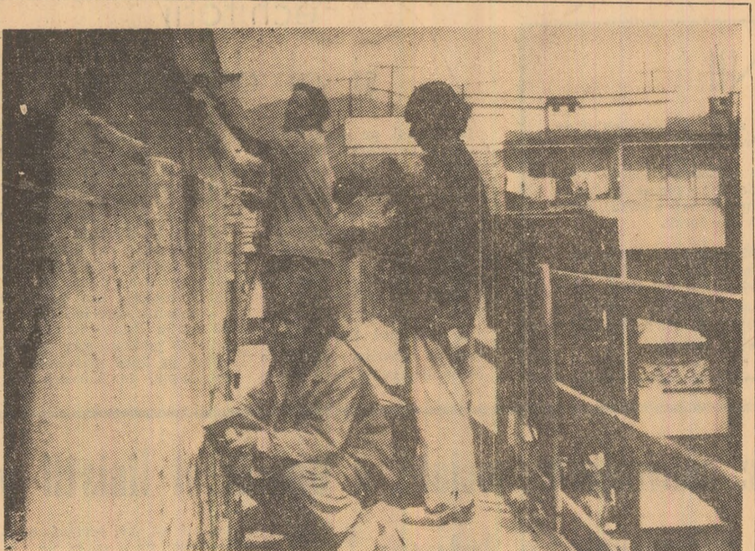
O parte din echipa de zidari de la T.C.H. lotul Petrosani condusă de comunistul Marin Rădulescu surprinsă pe binala ultimului etaj al noului bloc H3-2 care în cursul se va da în folosință oamenilor muncii.
