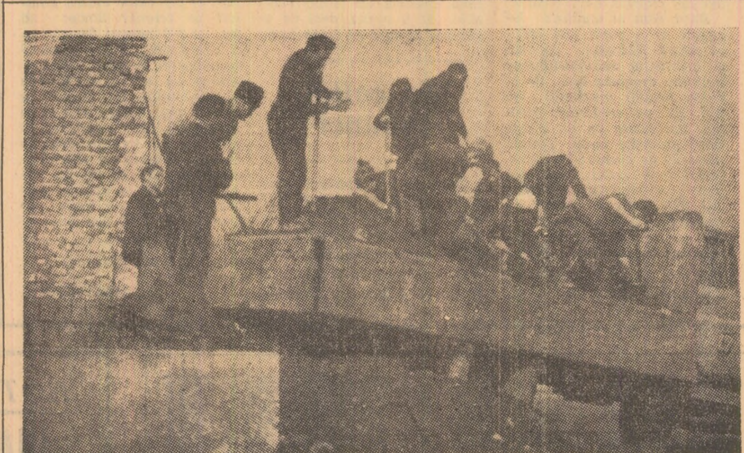
Zilele trecute a avut loc la Iscroni o acțiune de muncă patriotică la care, după cum ne relatează colaboratorul nostru Dan Iliescu, care ne-a transmis fotografia, au participat „cu mic cu mare” numeroși cetățeni la umplerea găului între fundațiile pe care anul acesta se vor mai ridica două săli de clasă.
