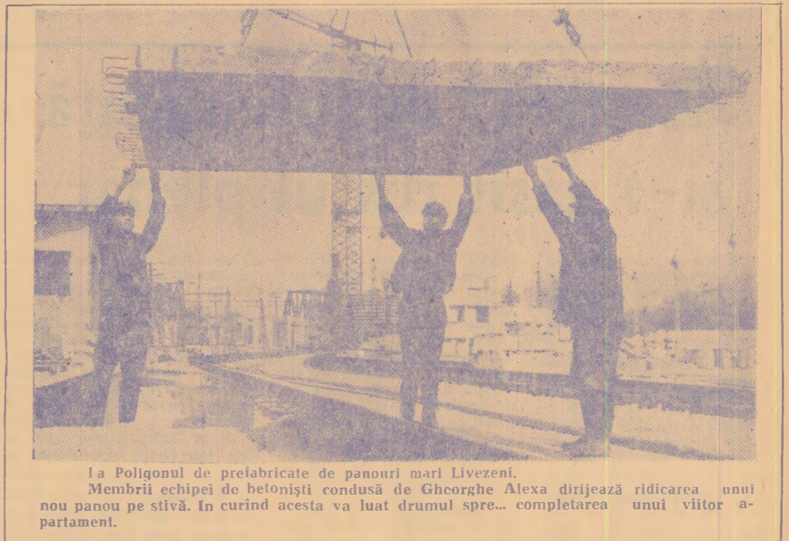
La Poligonul de prelucrare de panouri mari Livezeni. Membrii echipei de betonisti condusa de Georgehe Alexa dirijează ridicarea unui nou panou pe stivă. În curînd acesta va lua drumul spre... completarea unui viitor apartament.
