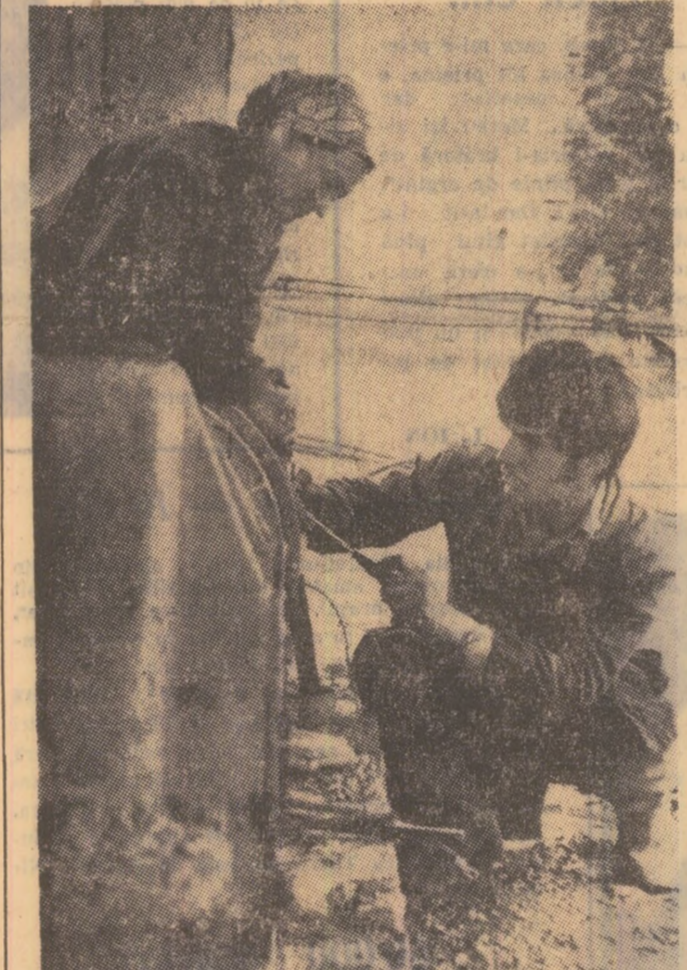
In dealul Livezeiului l-am surprins la stația de haldare a șteritului pe electricienii Eitel Boteratu și Constantin Ghilă în timpul branșării unui motor care va pune în funcție banda transportoare a șteritului. Foto: I. LICIU
