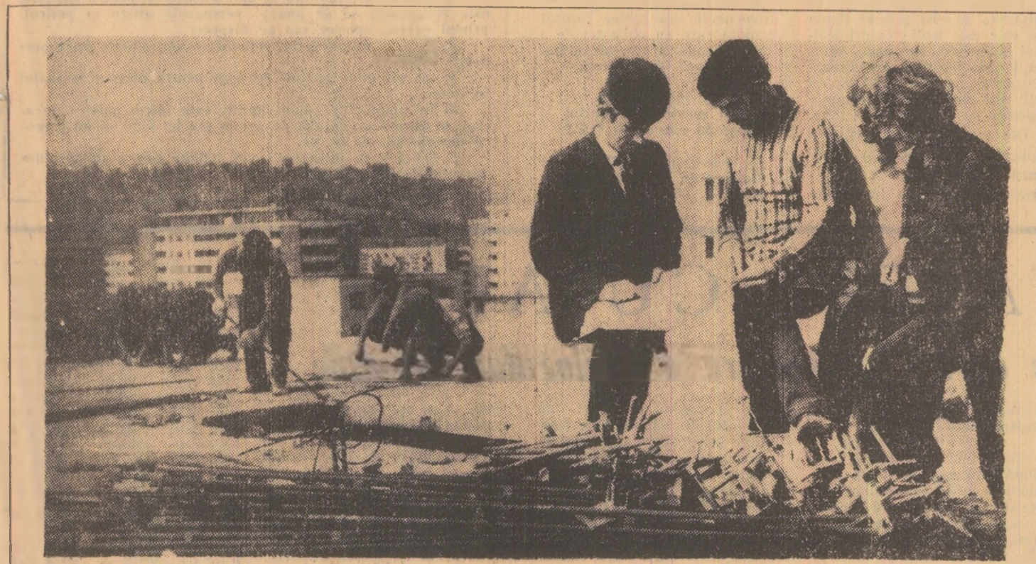
Montarea panourilor parterului unui bloc cu 4 etaje din cartierul Coroștii — Vulcan, se desfășoară conform planului. În instanțaneul nostru l-am surprins pe șeful brigăzii de montori prefabricate Zoltan Kispaal, maistrul constructor Francisc Filipescu și doi constructori — consultînd planul de execuție. Foto: Ion LICIU
