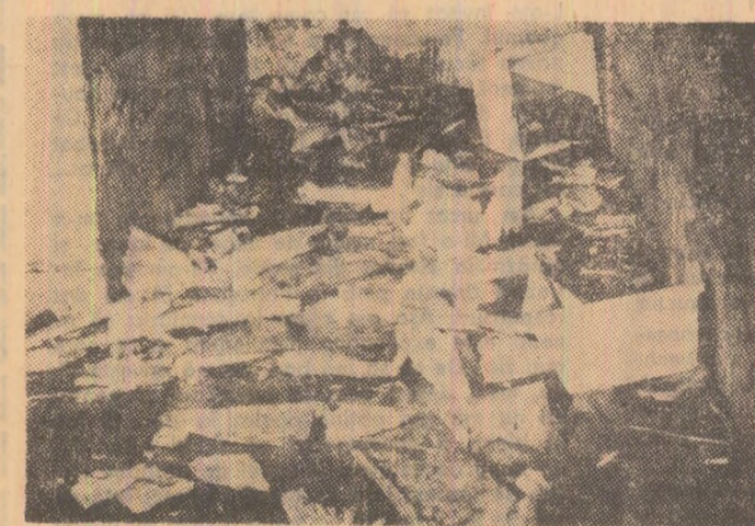
Chișeuș nr. 2 Modul de spargere a vaselor din polistiren umplute cu apă, care au oprit explozia de încercare din galeria Balmor — Uricani.
