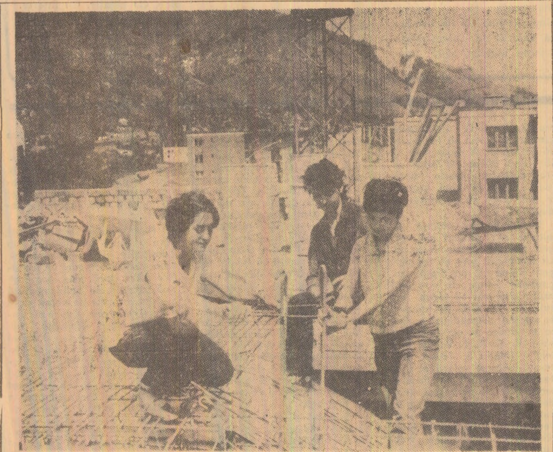
Pe planșeul etajului III al viitorului bloc P 2 B din Petrlia am asistat la una din operațiile construcției acestuia: execuția legăturilor din fier-beton a planșeului, operație care necesită o adevărată cunoaștere a muncii asidua și... multă artă. Într-unul din punctele de lucru am înregistrat pe peliculă în fier-beton-betoniste Tatiana Lapadatu, Maria Gîrteș și Elena Michi executînd legături din fier-beton la scarile etajului. Foto: I. LICIU
