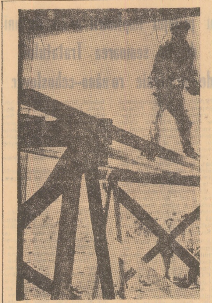
Zidoru Alexandru Nedea surprins de obiectivul aparatului nostru în timpul finisării halei de tâmplărie de la Livezeni aparținând I. L. Petroșani — hală, care după cum se pare în curând se va da în funcțiune.
