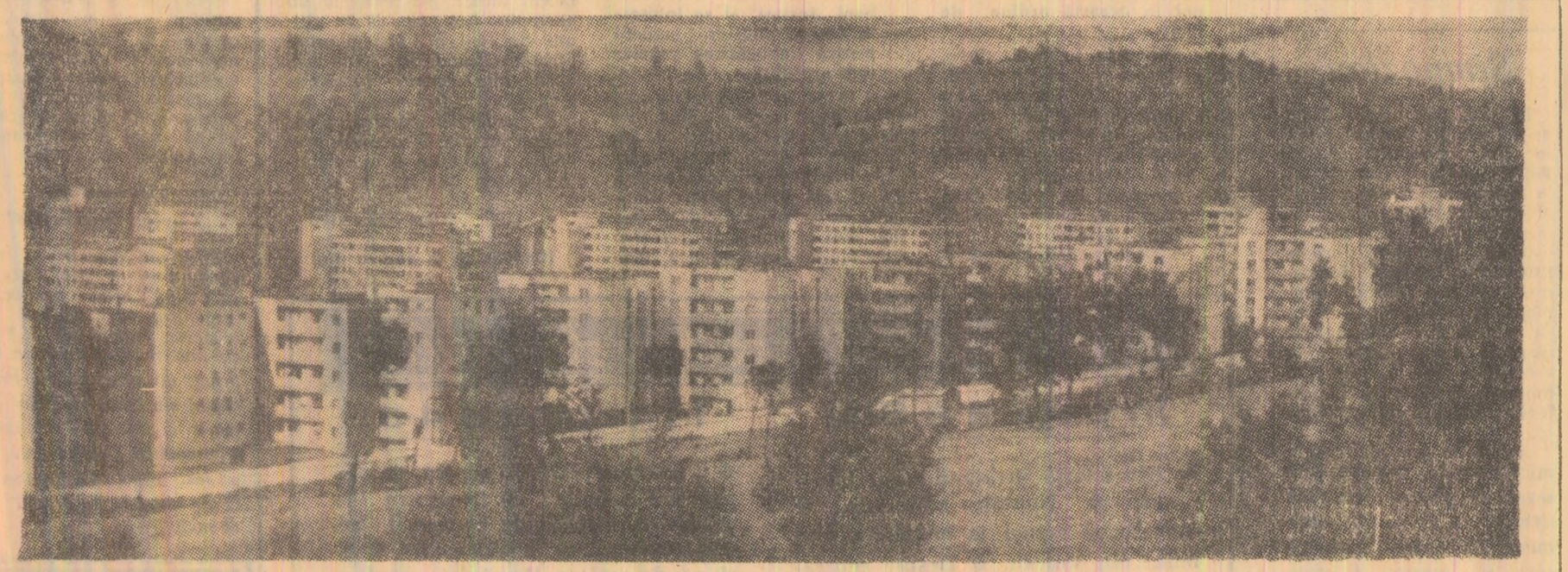
Noile cartiere, edificii somptuoase care materializează efortul și pricepera muncii constructorilor din Valea Jiului.
