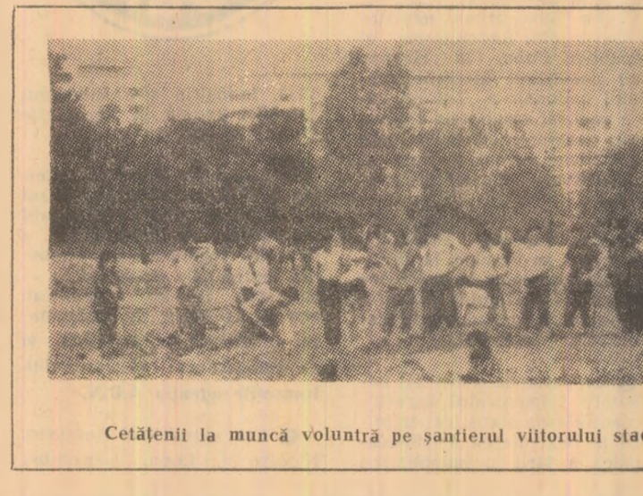
Cetățenii la muncă voluntară pe șantierul viitorului stadion al Vulcanului.
