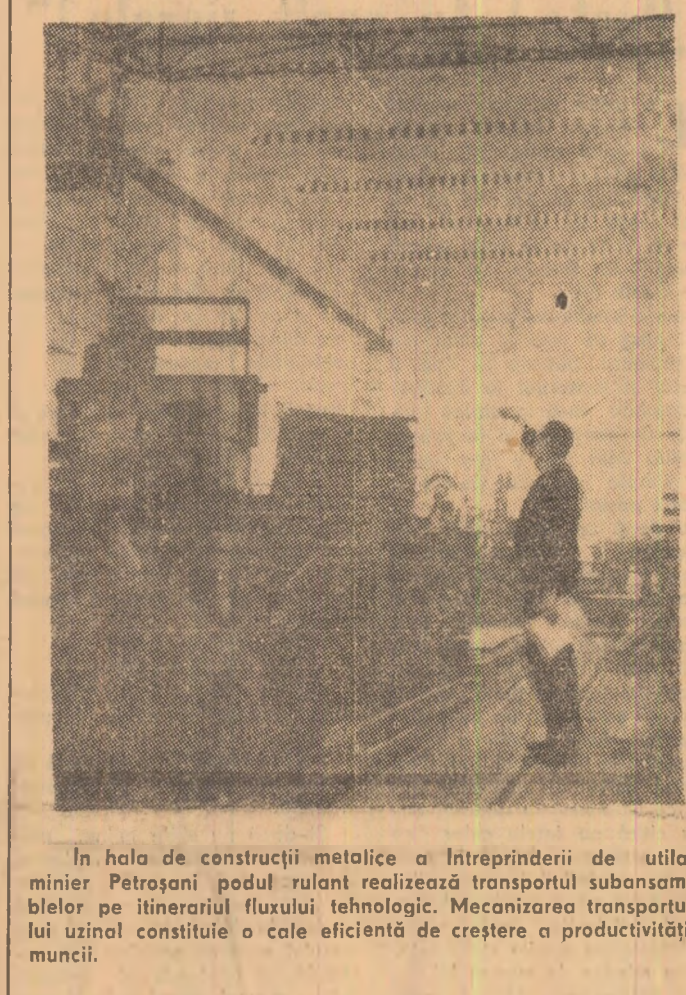
În hala de construcții metalice a întreprinderii de utilaj minier Petroșani podul rulant realizează transportul subsanșlelor pe itinerariul fluxului tehnologic. Mecanizarea transportului uzinal constituie o cale eficientă de creștere a productivității muncii.
