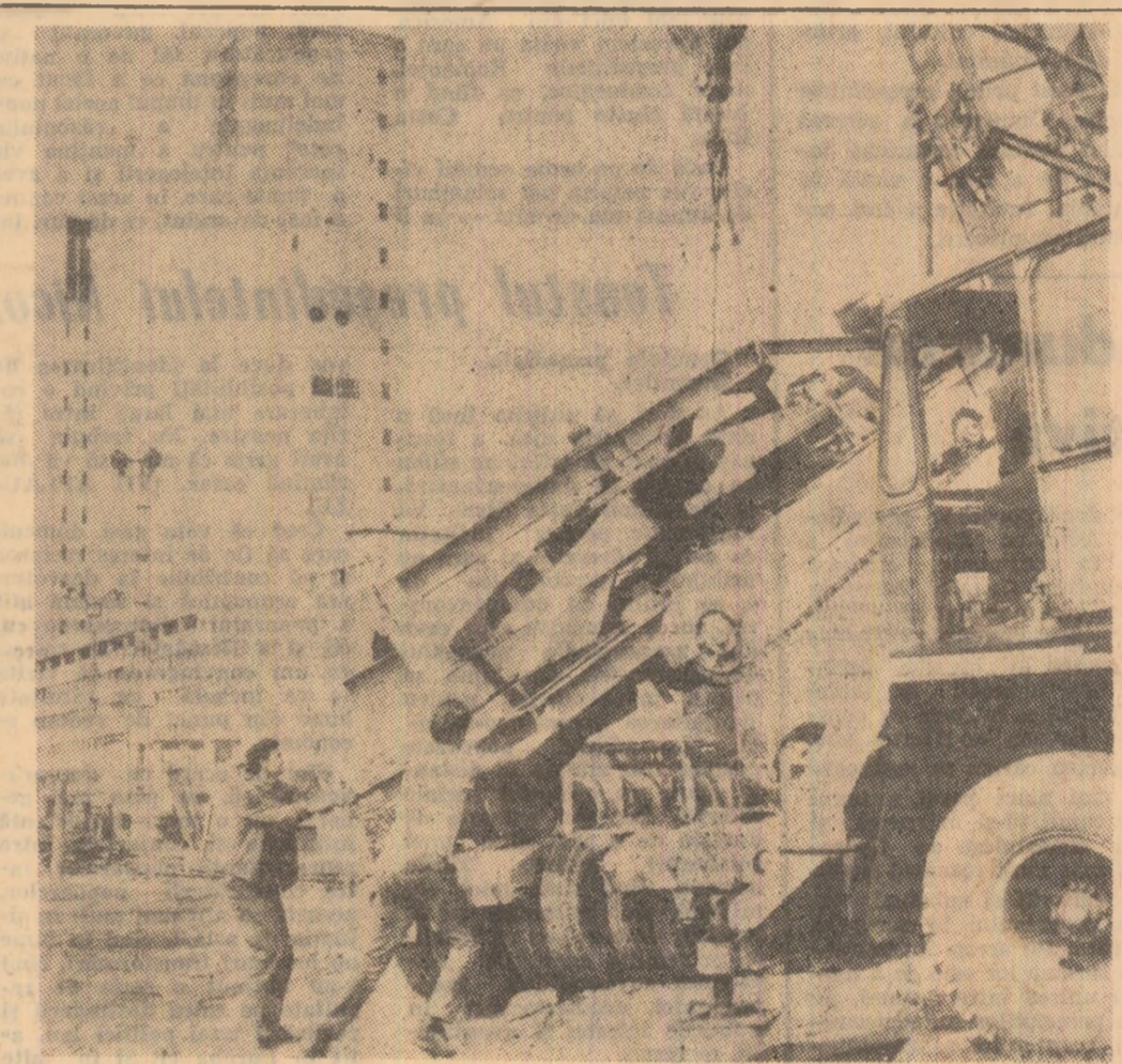
Comunistul Traian Stelescu — macaragiu la T.C.M.M., lăcătușii Aurel Șornea și Francisc Deneș surprinși de obiectivul nostru fotografic în timpul transportului unuia din deszăcrioarele care urmează să fie montate în stația de sortare a complexului minier de la Aninoasa — sectorul Livezeni. Foto: I. LICIU
