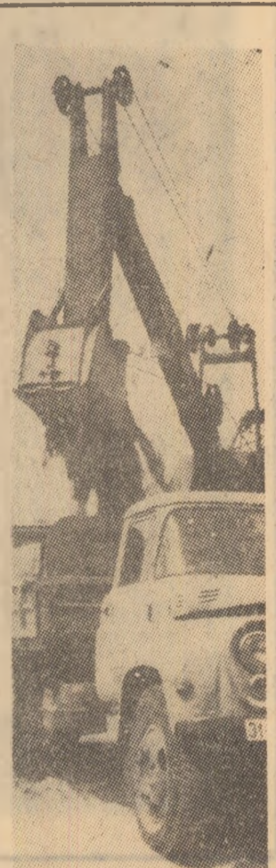
O nouă încărcătură de beton în drumul spre santier, din stația de betoane Petrosani.
