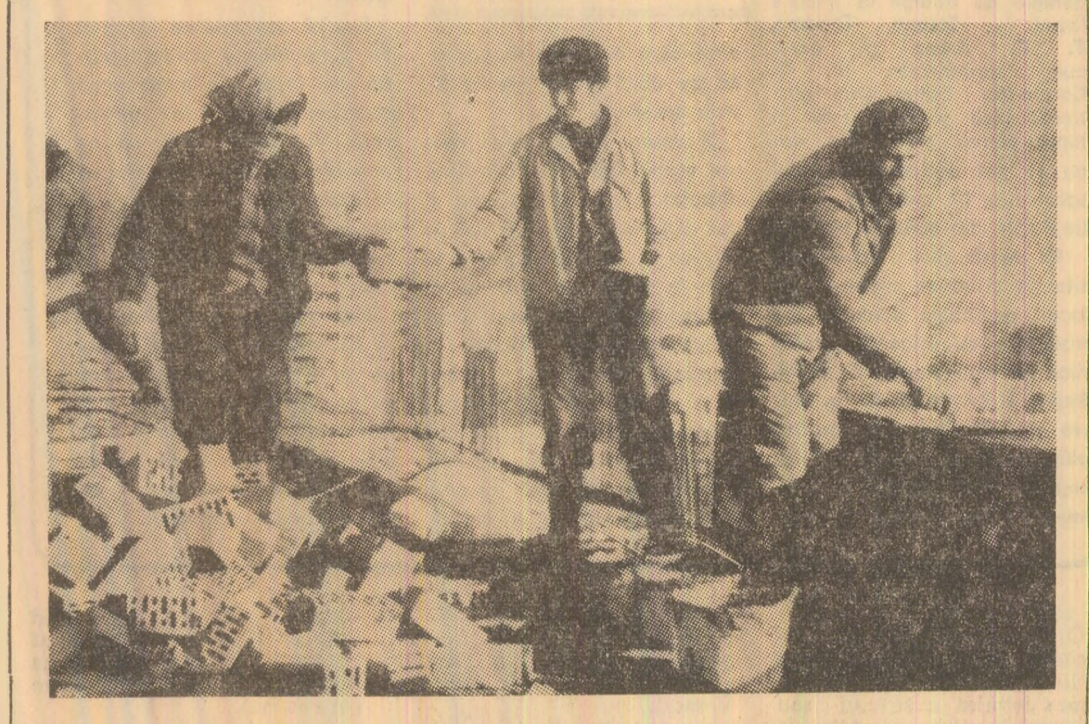
Pe gisantul turn A-2 din cartierul Coroștii — Vulcan constructorii au ajuns la cota finală. În clișeu, zidarii din echipa condusă de Mihai Dudaș fac „bordura” etajului 10.
