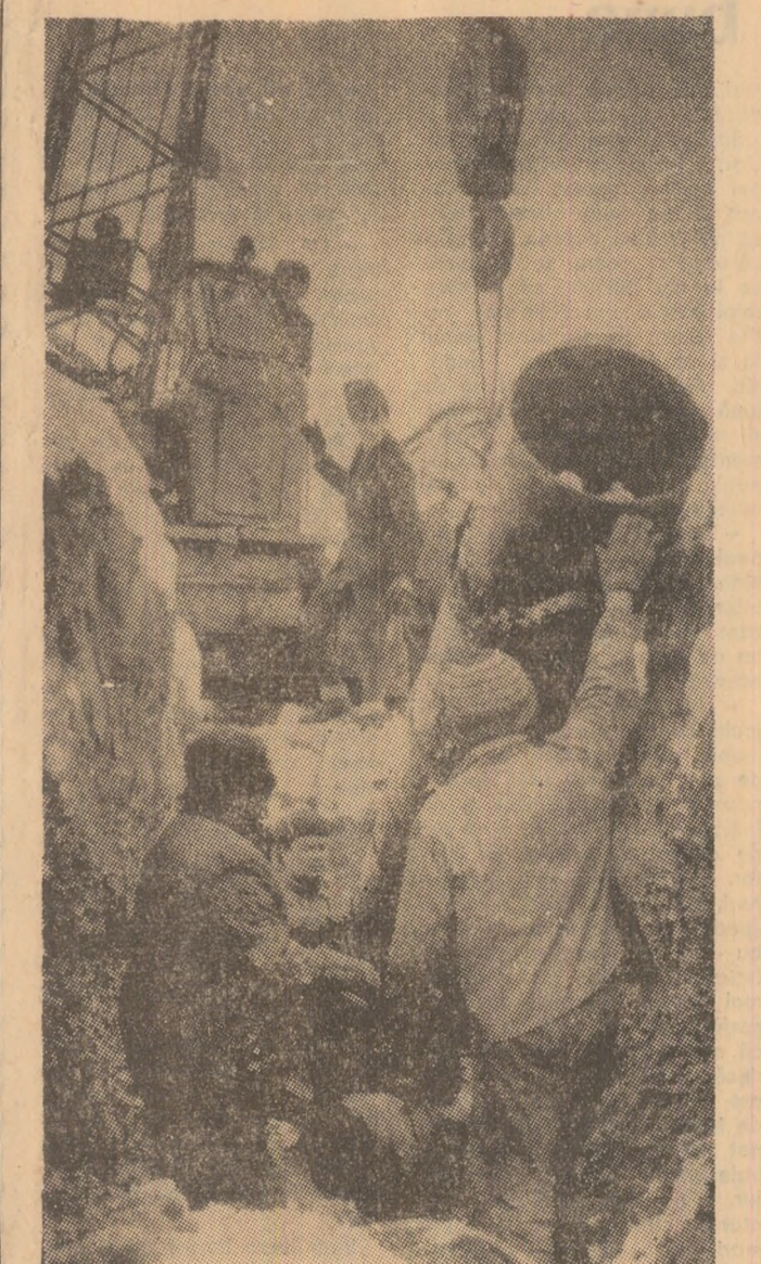
Echipa de instalatori-sudori de la T.C.M.M., condusă de Gheorghe Dragnea surprinsă la subtraversarea conductei de 500 mm la punctul de trecere pe sub șoseaua națională, condusă care va alimenta cu apă, de la Valea de Pești cartierul Aeroport din Petroșani. Foto: I. LICIU
