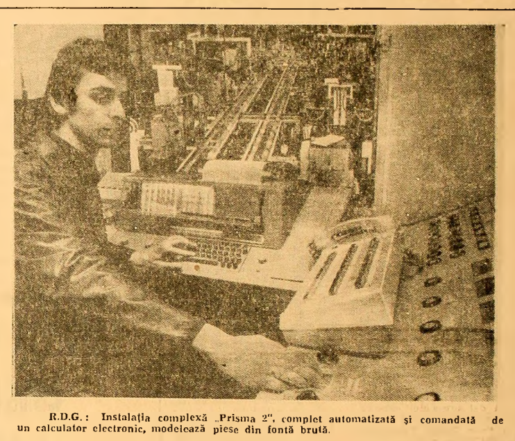
R.D.G.: Instalația complexă „Prisma 2”, complet automatizată și comandată de un calculator electronic, modelează piese din fontă brută.
