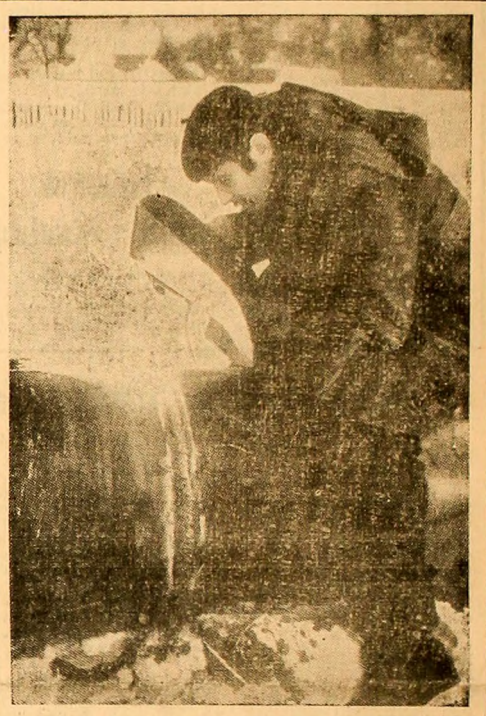
Tinărul sudor Adalbert Biro de la T.G.M.M. lotul Ii-vezeni surprins de obiectivul aparatului nostru sudind conducta de apă de 500 mm care va alimenta Petroșaniul cu apa din bazinul barajului de la Valea de Pești. Foto: I. LEONARD
