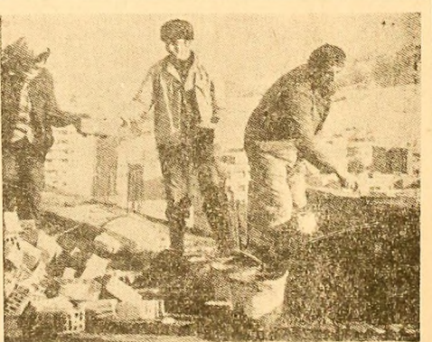
Șantiierul de construcții Vulcan. Ca întotdeauna, echipa de zidari condusă de Mihai Dușeaș și la... înalțime. Foto: Ion LICIU
