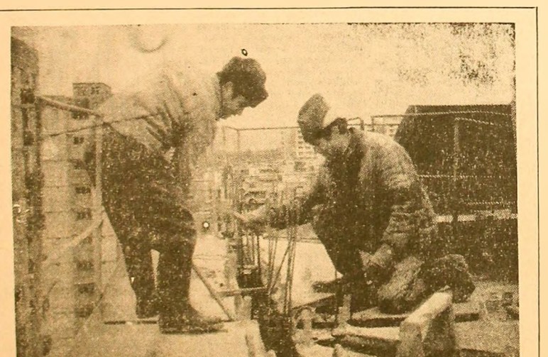
Seful echipei de dulgheri Constantin Ebincă și dulgherul Nicolae Pălimaru de la T.C.H. lotul Vulcan operind la unul din cofrajele etajului VI a noului turn de locuințe A-3 din cartierul Coroești. Foto: Ion LICIU
