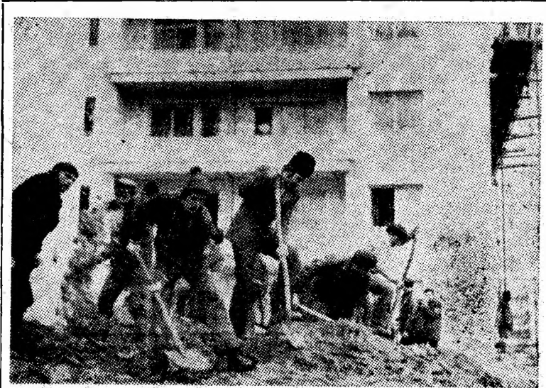
Muncitori, tineri și vîrstnici, de la fabrica de oxigen organizați în subunități A.L.A. dau, în aceste zile, un apreciat ajutor constructorilor la săparea fundațiilor de la viitorul bloc O 2-3 din cartierul Aeroport Petroșani. Acest ajutor continuă în mai multe puncte ale șantierului T.C.H. Petroșani, unde își aduc contribuția oameni din mai multe întreprinderi ale municipiului nostru.
