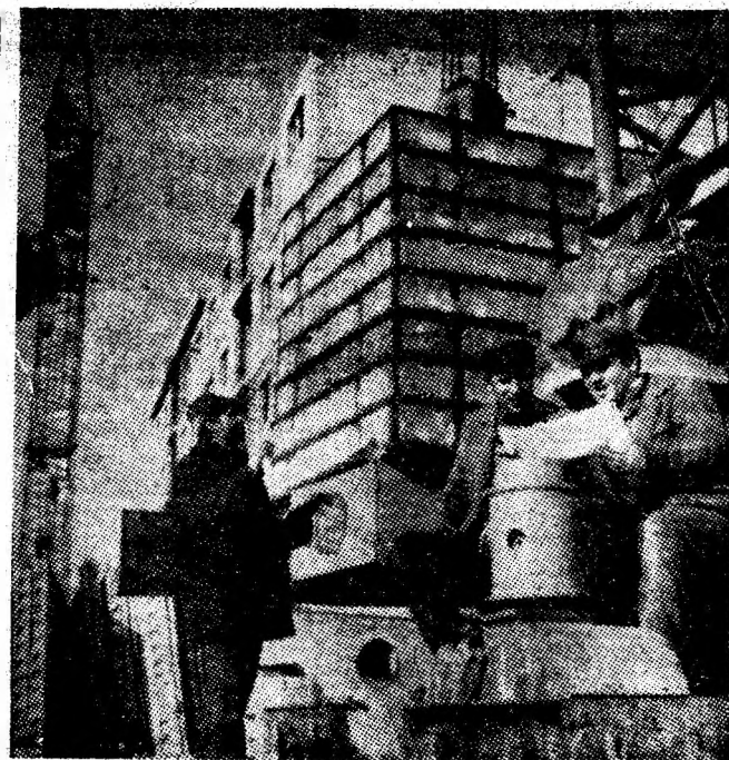
Macaragii Zamfir Hobeanu, Dumitru Arhip și Gheorghe Rusu au terminat montarea macaralei de 110 to/m, iar acum verifică funcționalitatea în vederea ridicării noului tronson al blocului de locuințe O-19 din cartierul Aeroport-Petroșani.
