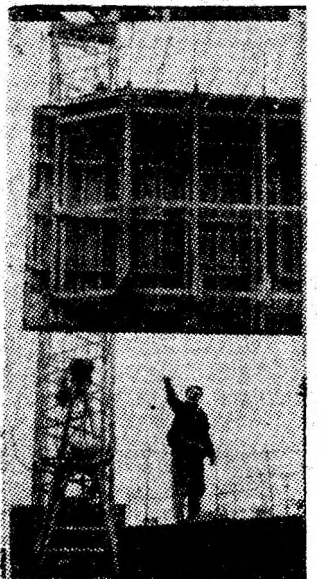
Pe șantierul de locuințe din Lupeni a început construcția unui nou bloc cu 20 apartamente care va fi predat pînă la finele lunii aprilie a.c.
