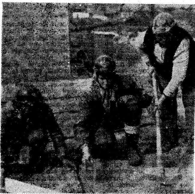
Uricani. Ana Voinea, șef de echipă, Maria Simion și Margareta Szilagy execută izolarea unui nou bloc din cartierul Bucura.
