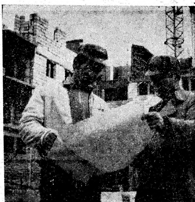
Șeful echipei de zidari Gheorghe Savin și maistrul constructor Emil Surdu de la lotul Vulcan al T.C.H. verifică planul de execuție a blocului I-M.
