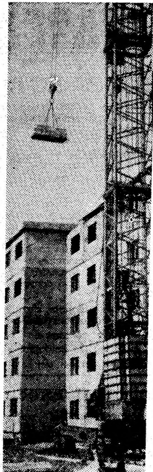
Prefabricatele viitoarelor blocuri de locuit, sint purtate de brațele de oțel ale macaralei spre înălțime.
