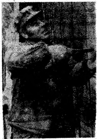
Comunistul Ion Buscă de pe șantierea Vulcan. Electrician destoinic, montează instalația în blocul M1 din viitorul centru civic al Vulcanului.
