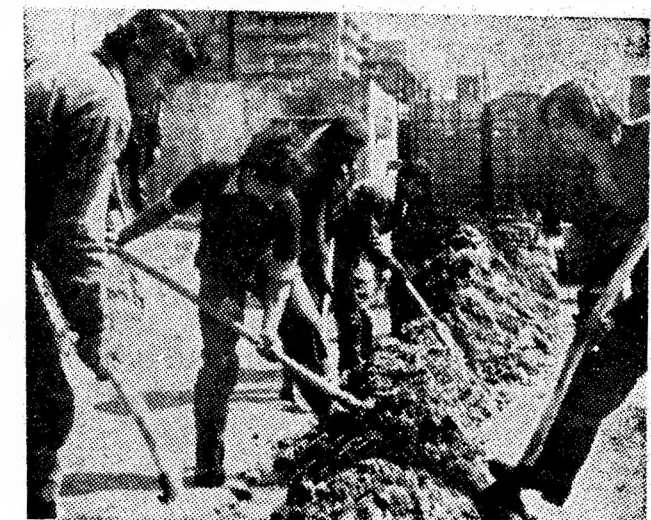
Toată Valea este un șantier. În cișeu: utescii de la mina Aninoasa dînd o mîină de ajutor constructorilor pe șantierul din centrul Petroșaniului.
