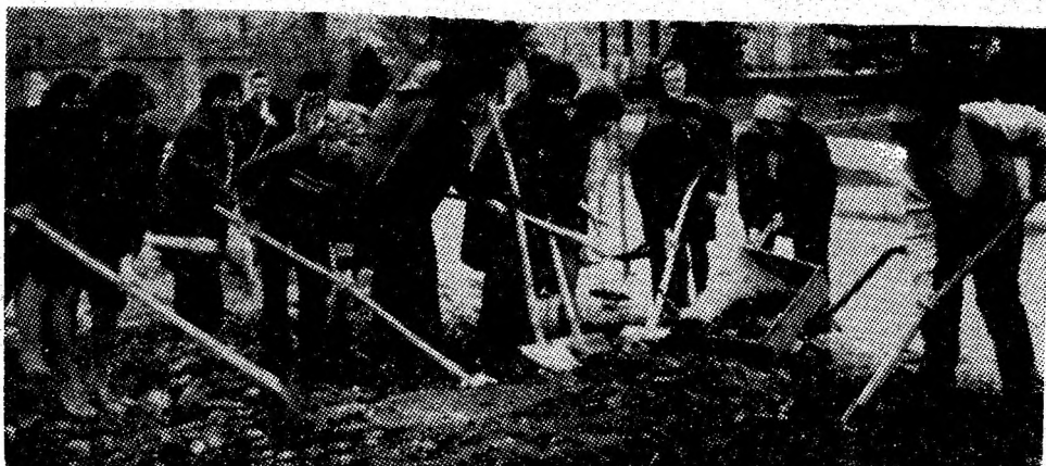
Lucrătoare ale băncii și C.E.C.-ului venite în sprijinul constructorilor, pe șantier.
