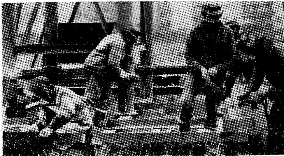
Șantierul fabricii de confecții Vulcan. Sub coordonarea maistrului Ioan Pop echipele conduse de Gheorghe Krausz și Gheorghe Bumba execută primele lucrări de organizare pe șantierul acestui însemnat obiectiv al dezvoltării social-economice a Văii Jiului, în actualul cincinal.
