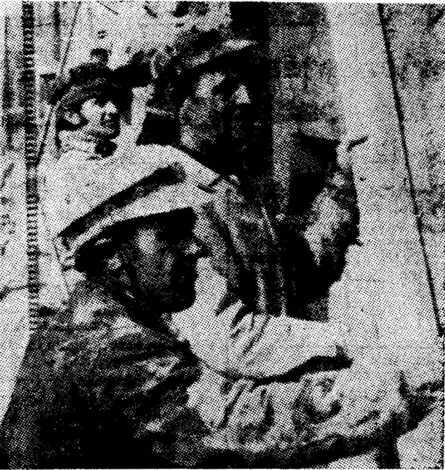
Echipa de zidari a constructorului Nicolae Avram în plin lucru la blocul M-16 din cartierul Bucura — Uricani.
