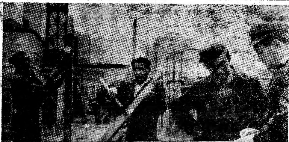
Consult asupra execuției noului bloc turn 69 din Petroșani, între maștrul principal constructor Constantin Alb și ajutorul șef de echipă, dulgherul Ion David.
