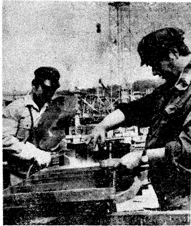
O imagine de muncă înfățișă zilnic pe șantierele viitoare preparării de la Livezeni.
