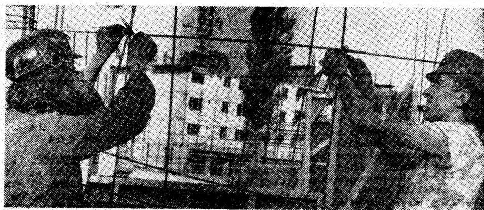
Tineri constructori. Mîinile lor „jes” temelia viitoarelor edificii social-culturale.
