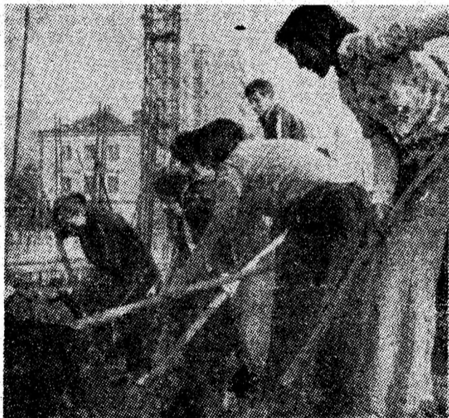
Angrenați într-o efervescentă acțiune de muncă patriotică, tinerii de la Grupul școlar minier Petroșani ajută constructorii de pe șantierul de lo-cuințe.
