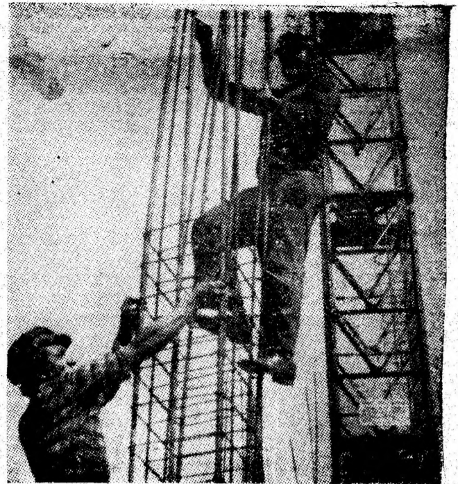
Dulgheriu Ion Popescu și Mihai Pavel „impletesc” țesătura de metal de la primul nivel al noului bloc turn ce se înalță în viitorul centru al Petroșaniului. Foto: Ion LICIU
