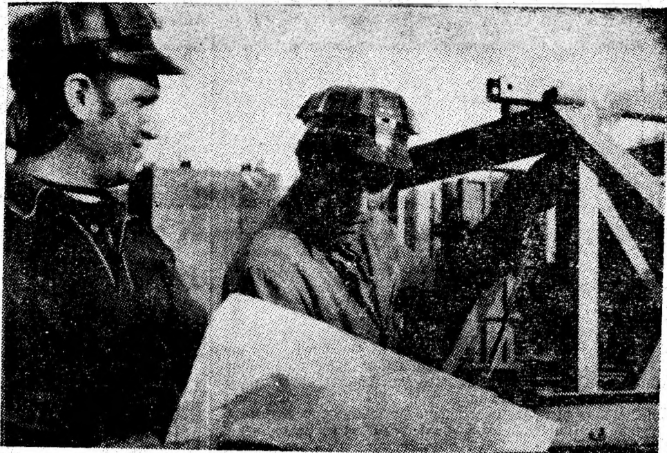
Șantierul de locuințe Vulcan. Comunistul Milică Tăbăcaru și șeful echipei de instalatori Pețu Mantea, sortează cofrajele noului bloc nr. 3 care în final va avea 8 nivele și 64 de apartamente. Foto: Gh. OLTEANU
