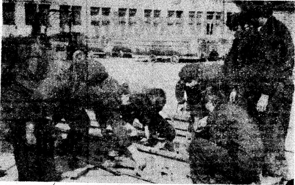
Pe terenul din fața atelierului electromecanic al minei Lonea, un grup de tineri meseriași conduși de Iosif Melzer și Gheorghe Robică muncesc la asamblarea unui nou complex mecanizat. Foto: D. CRIȘAN
