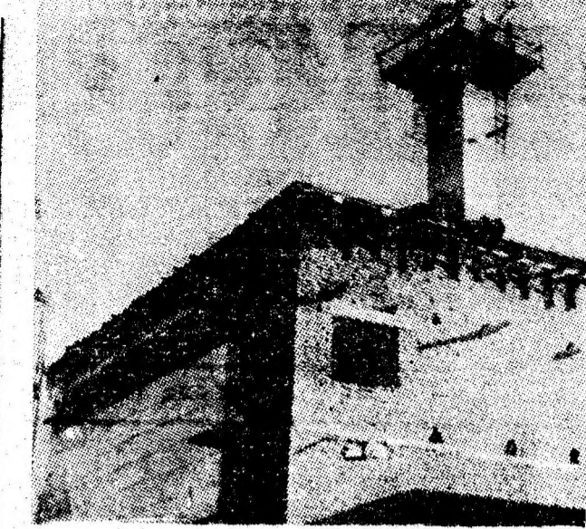
În cartierul Viscoza din Lupeni se construiește o nouă centrală termică ce va alimenta cu apă caldă și căldură noile blocuri din cartier.
