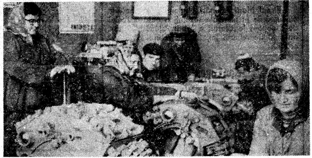
În atelierul electric al I.M. Uricani echipa de reparat contactoare condusă de Petru Ianc repară un lot de intrerupătoare pentru subteran. Foto: Ion LICIU
