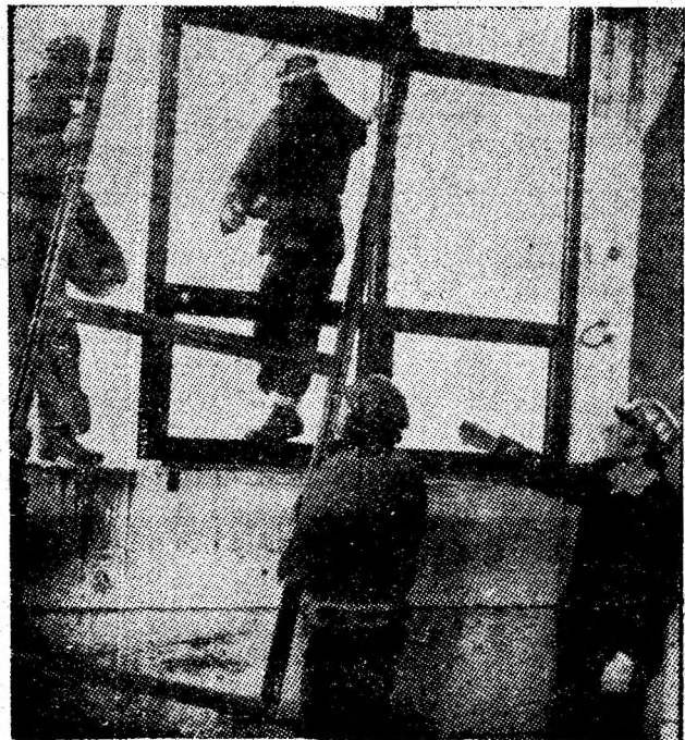
Echipa de lăcătuși condusă de Ion Vereș montează ferestrele metalice la noua hală a Fabricii de confecții din Vulcan.
