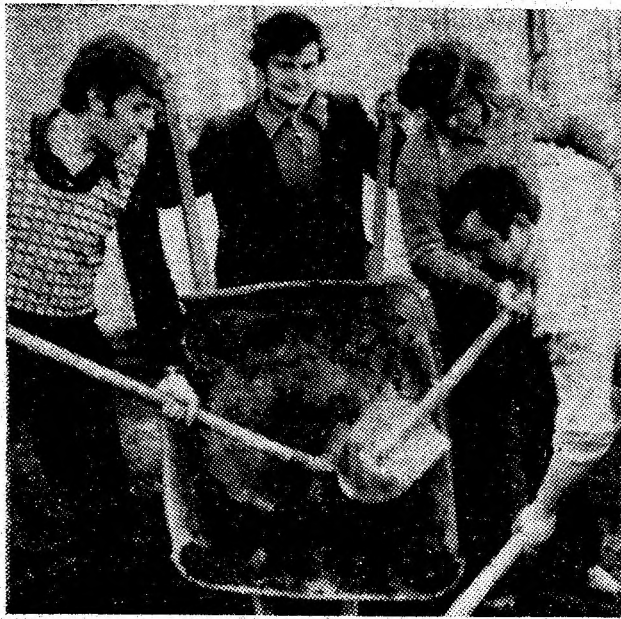
Instantaneu surprins, miercuri, pe Aleea Victoriei din Lupeni. Se amenajează zona verde din fața blocului M2.
