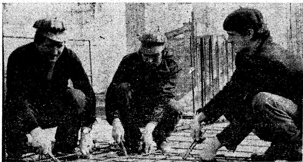
Echipe de fierar betonisti a lui Alexandru Ionculescu „fese” armătura metalică la cota 10—70 a noii preparații Livezeni.
