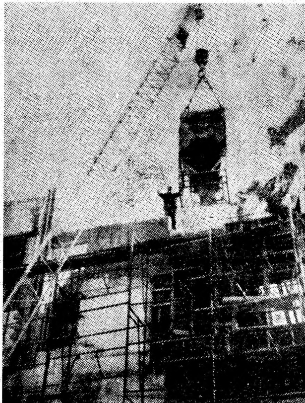
Ritm susținut de lucru pe șantierul fabricii de confecții din Vulcan.
