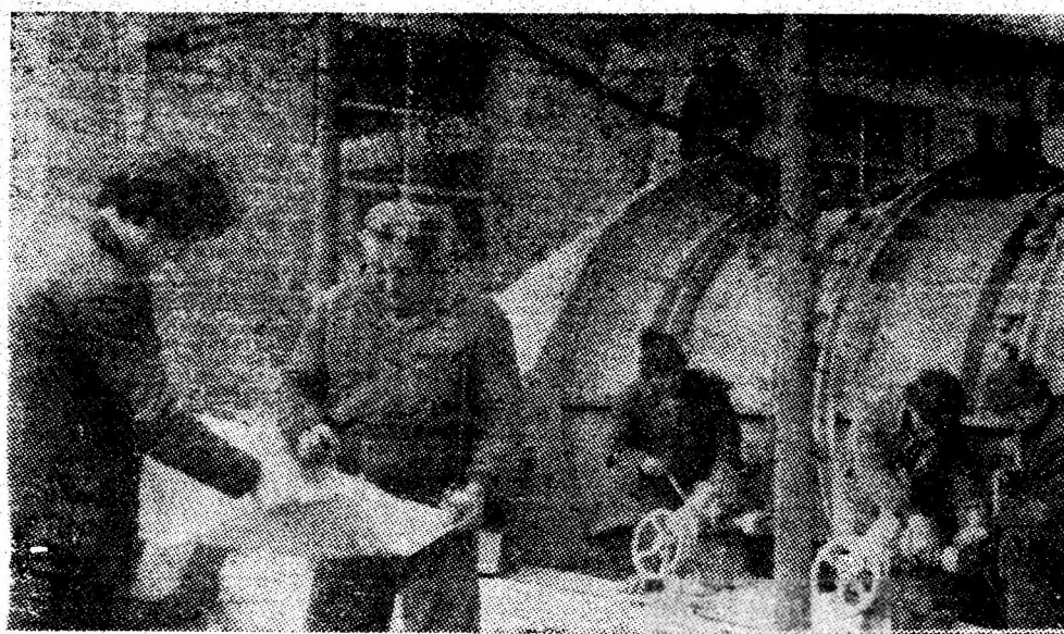
Șeful echipei de lăcătuși Vasile Iacobescu și maestrul Ion Cîrstea fac ultimele verificări la execuția stației de aeraj de la Uricani-Est, aflată în curs de finisare.
