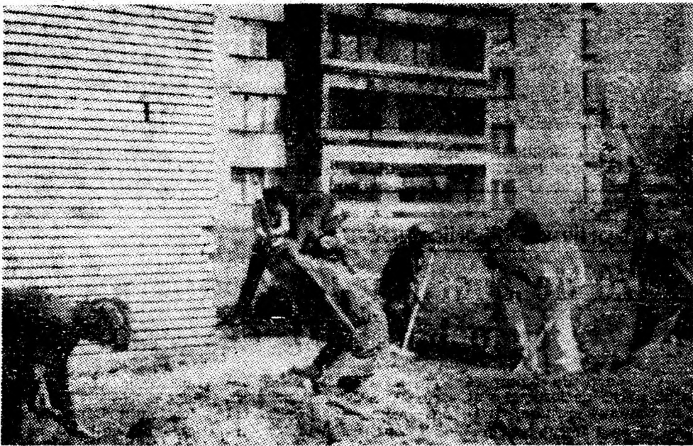
Tineri de la I.U.M. Petroșani pe șantierul de construcții a viitoarelor locuințe.
