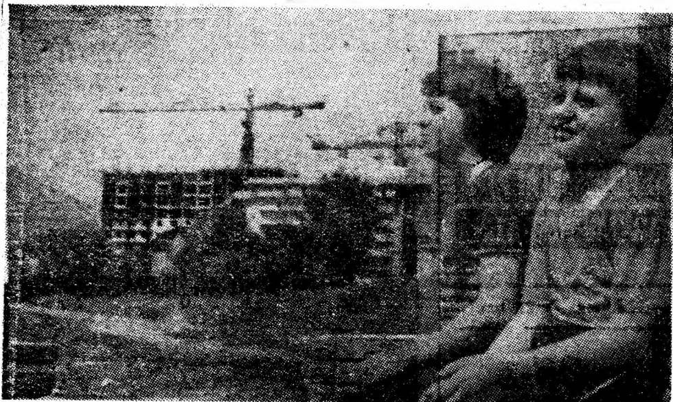
In noul centru civic al orașului Petroșani se confuzionează un nou bloc de locuințe. La blocul 69 se toarnă cel de al zecelea etaj al tronsonului II.
