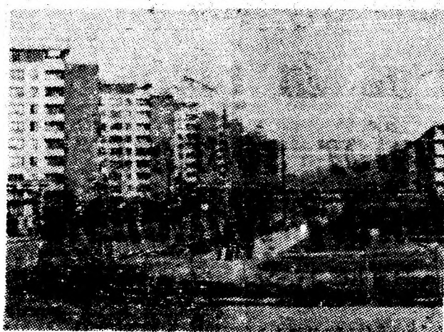
Noi și moderne blocuri se integrează armonios în urbanistica Văii Jiului. Foto: Șt. NEMECSEK
