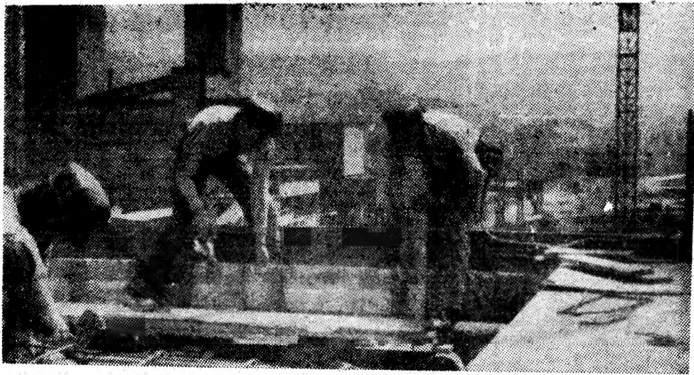
Șeful de echipă Vasile Codoreanu împreună cu dulgherii Aurel Nemțeanu și Constantin Folache executînd planșeurul în consolă la secția sortare a noii preparații din Livezeni.
