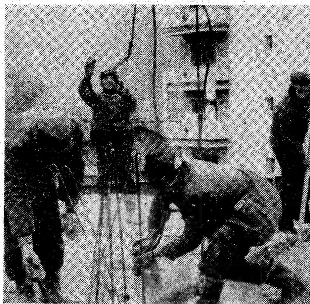
Echipa de dulgheri condusă de Ion Furdul montează planșee la noul bloc A6 din Lupeni, bloc ce va însuma în final 5 nivele și 35 de apartamente.
