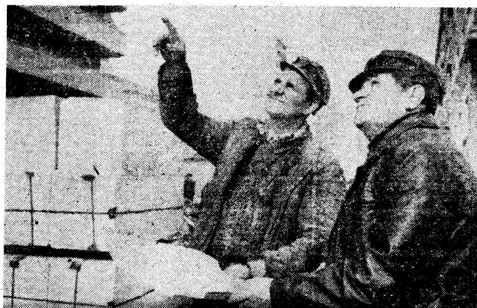
Doi veterani de nădejde ai șantierelor de locuințe din Petroșani — maistrul constructor Constantin Albu și dulgherul Gheorghe Neagoe. (Foto: I. LICIU)
