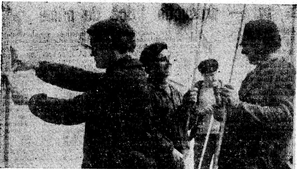
Echipa de zidari condusă de comunistul Gheorghe Radeș executînd lucrările de finisare la fațada blocului 21 AB din Vulcan.
