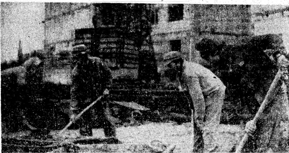
Prin munca acestor oameni pîind contur sutele de apartamente în noile blocuri. În imagine zidari din brigada lui Nicolae Popescu surprinși în timp ce preparau mortar la blocul 18 din viitorul centru civic al orașului Vulcan.
